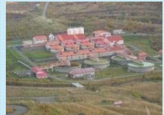
(坑廃水処理施設の例)
