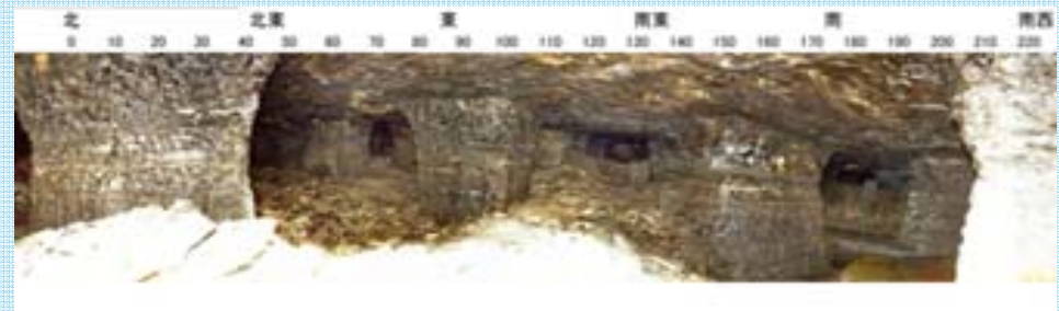
空洞カメラによる地下空洞の画像
