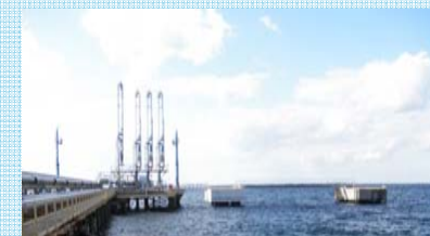
※ 製品出荷棧橋の土台
