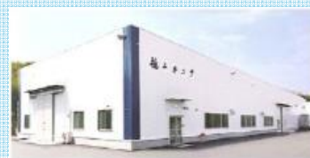
倒壊した工場・施設等の復旧支援
